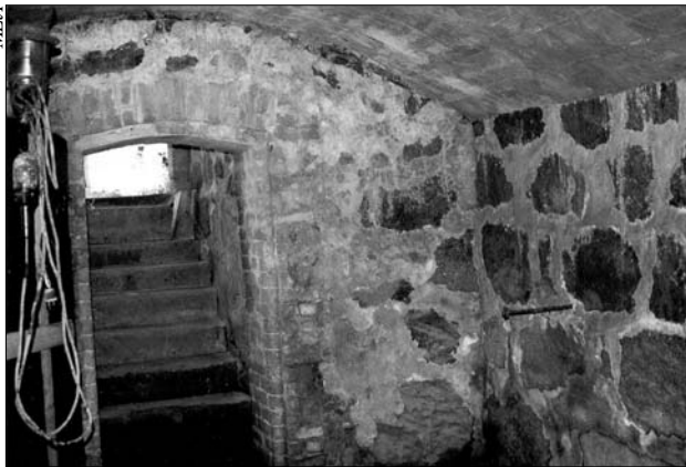
Погреб, в котором были убиты евреи Малты (современный вид). Изнутри через дверной проем видны тамбур и выход наружу
